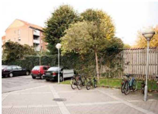
I afdeling 106 - Vognvænget pågår en større renoveringssag, hvor der bl.a. skal udføres betonreparation af p-kælder med ny belægning.
