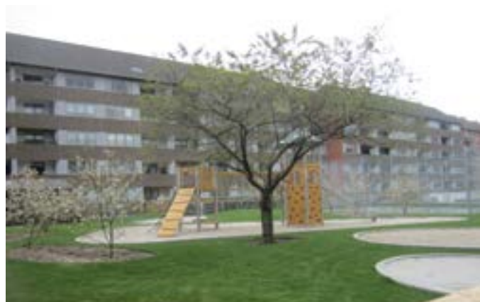
Det ikke helt færdige gårdanlæg i afdeling 108 - Bogtryknergården.
