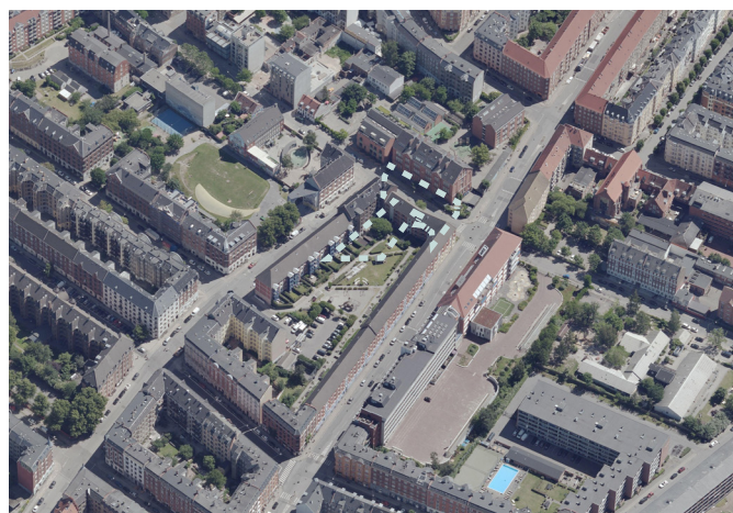
Luftfoto af Rådmandsgade afd. 175 med kig ind i gårdrummet.
