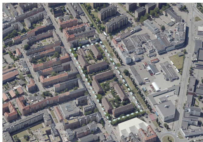
Luftfoto af Støberigården I + II.
