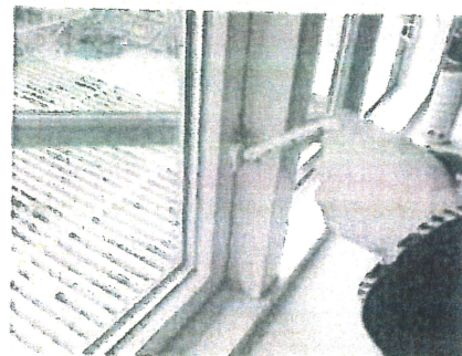
8. Ramme lukkes. Husk sikringsbeslag skal stå lodret for at føres gennem slids.
