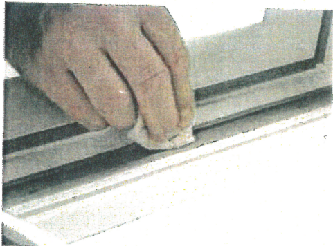
Bundskinne rengøres grundigt med klud rengøringsmiddel ved stærk tilsmudsning
