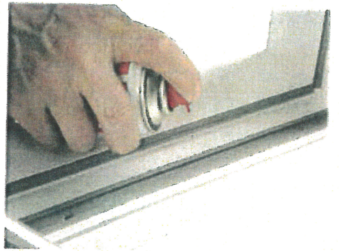
Efterfølgende smøres vinduet med special syrefri sprayolie.
